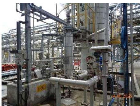
ภาพที่ 2.2-21 อุปกรณ์ควบคุมการไหล อุปกรณ์วัดความดัน และอุณหภูมิสัญญาณเตือนและวาล์วนิรภัย
