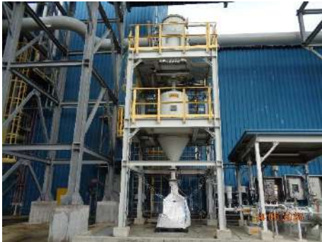
ภาพที่ 2.2-31 ระบบรวบรวมฝุ่นและภาชนะรองรับฝุ่นจาก บริเวณที่มีการฟุ้งกระจายของสารเคมีแต่ง
