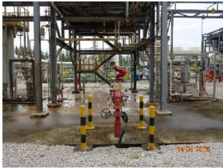
หัวฉีดน้ำดับเพลิง (Fire Monitor)
