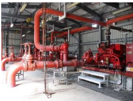
ภาพที่ 2.2-35 เครื่องสูบน้ำแบบเครื่องยนต์ดีเซล
