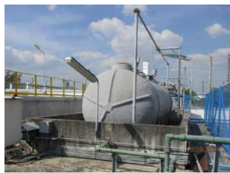
ภาพที่ 2.2-4 ถังบำบัดน้ำเสียสำเร็จรูป (SATs)
