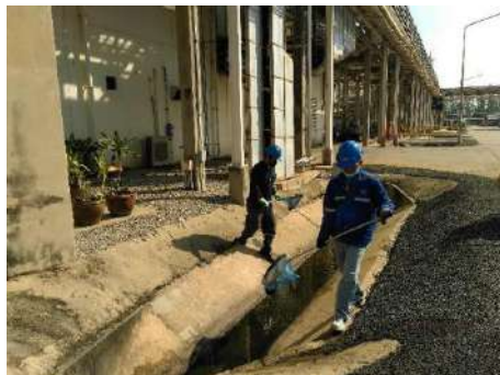
ภาพที่ 2.2-8 การทำความสะอาดรางระบายน้ำฝน
