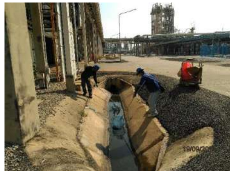
ภาพที่ 2.2-8 การทำความสะอาดรางระบายน้ำฝน
