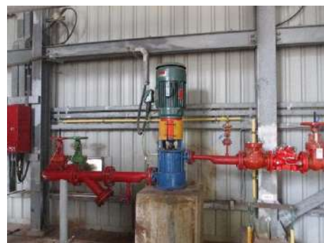
ภาพที่ 2.2-35 เครื่องสูบน้ำรักษาแรงดัน (Jockey Pump)
